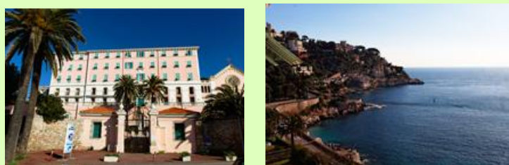
Maison du Séminaire in Nice
